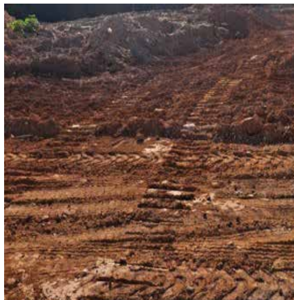
Aterramento de canal provisório
