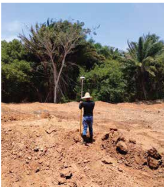
Equipe de topografia verificando pontos e cotas executivas.
