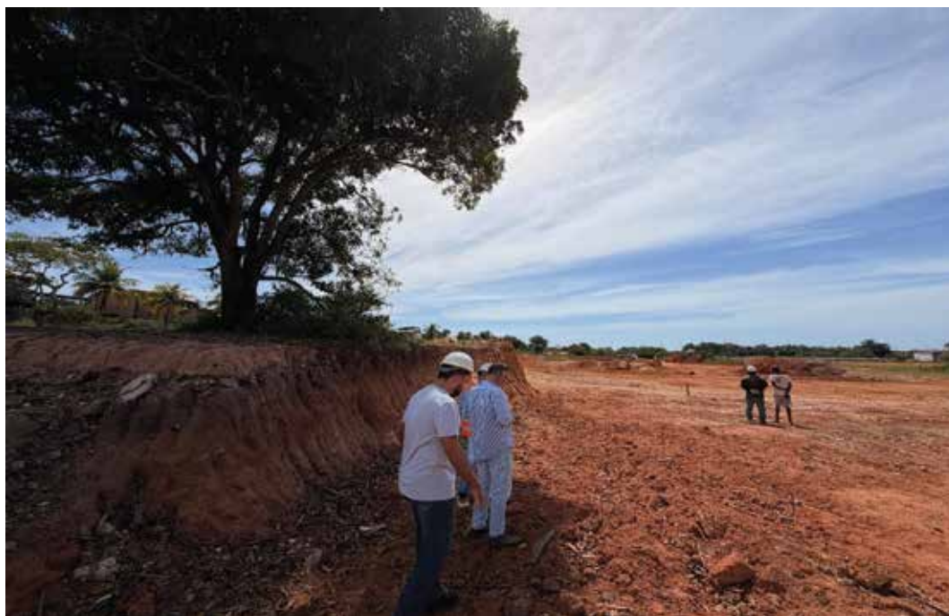
Visita técnica – Análise de solo/terraplanagem.
