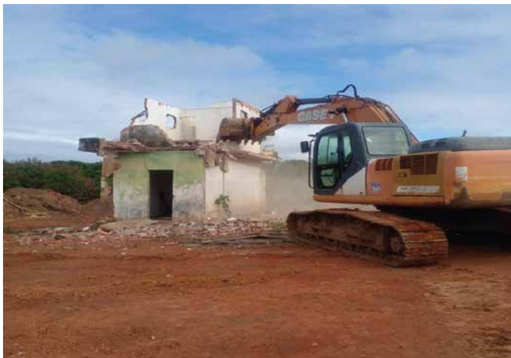
Demolição de imóvel
