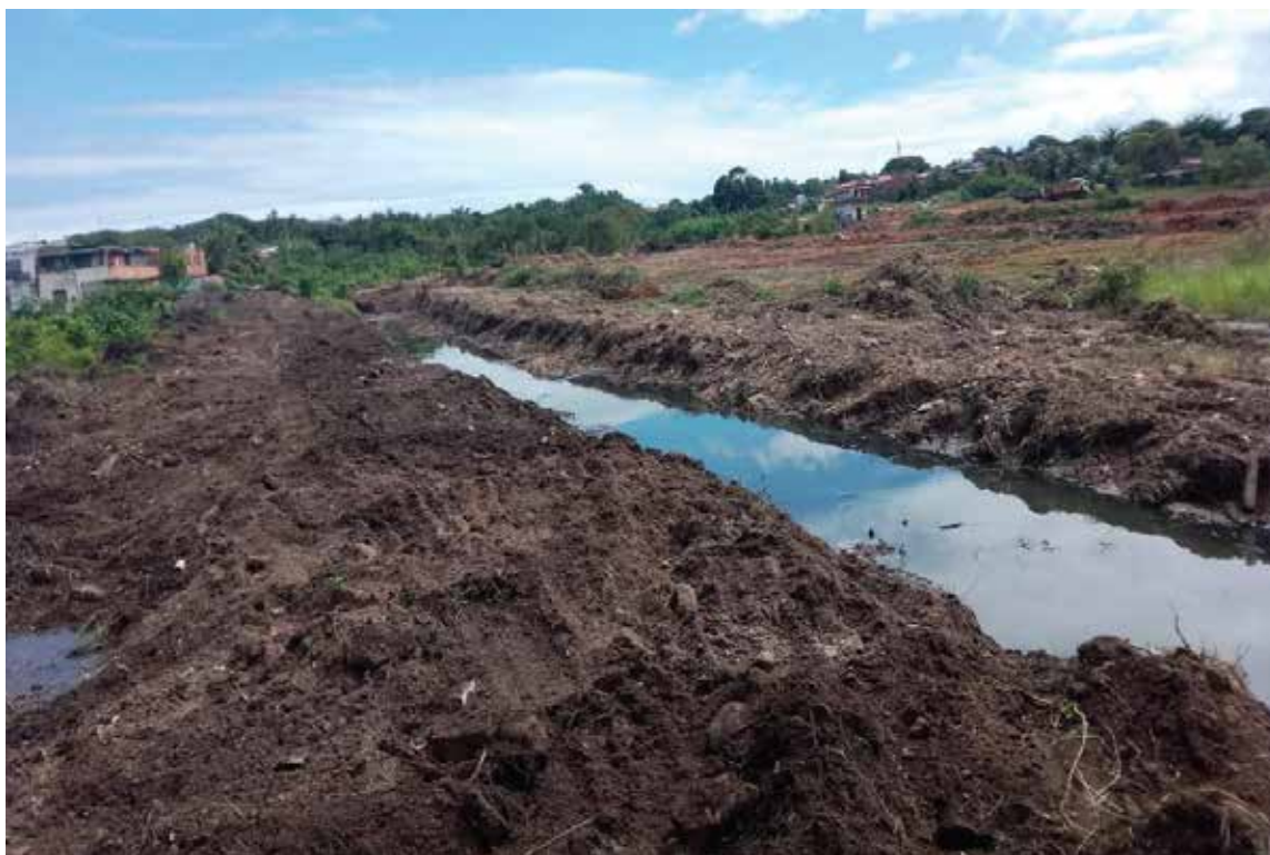
Canal provisório – retirada de matéria orgânica e demais sujidades
