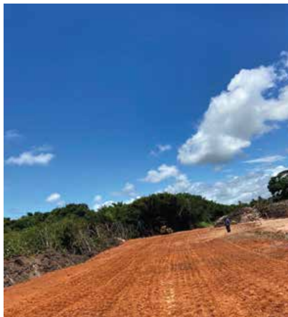
Compactação de solo
