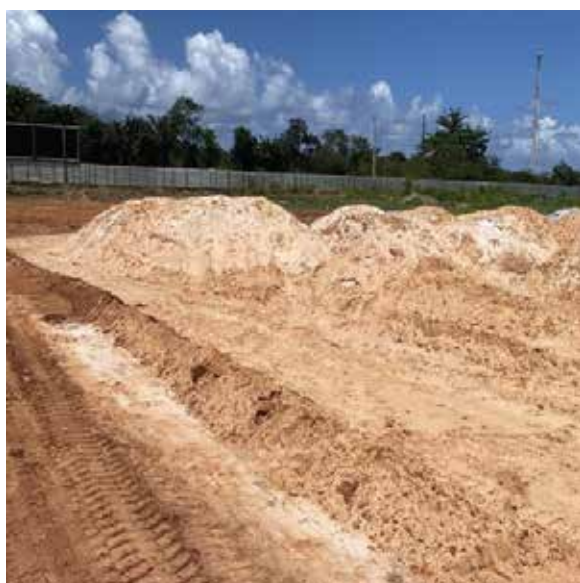
Material para realização de aterro do canal provisório
