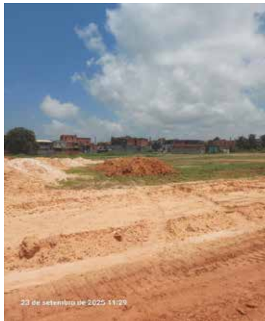
Movimentação de material de jazida
