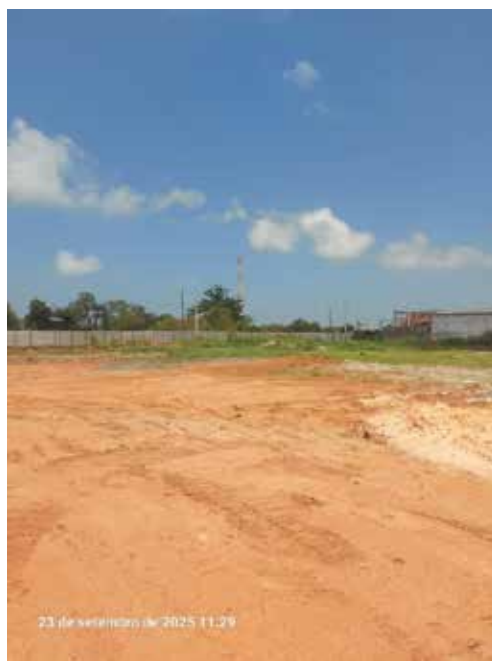
Movimentação de material de jazida
