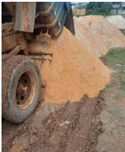
Movimentação de material de jazida
