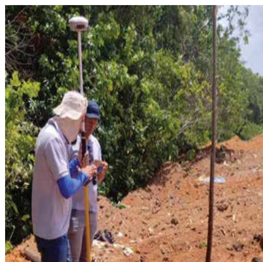
Equipe de topografia verificando pontos e cotas executivas.
