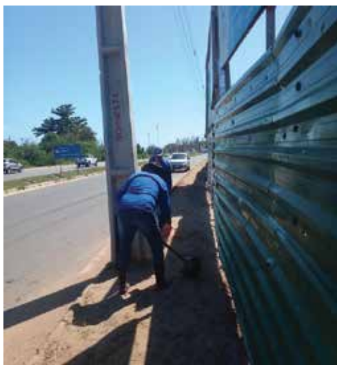
Execução de tapume frontal
