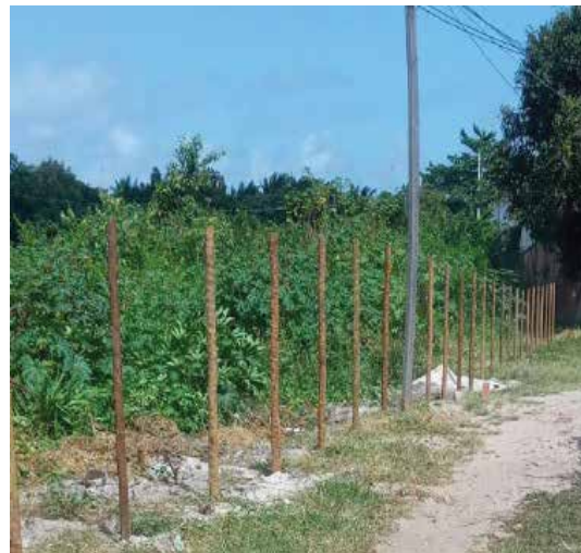
Execução de cerca perimetral
