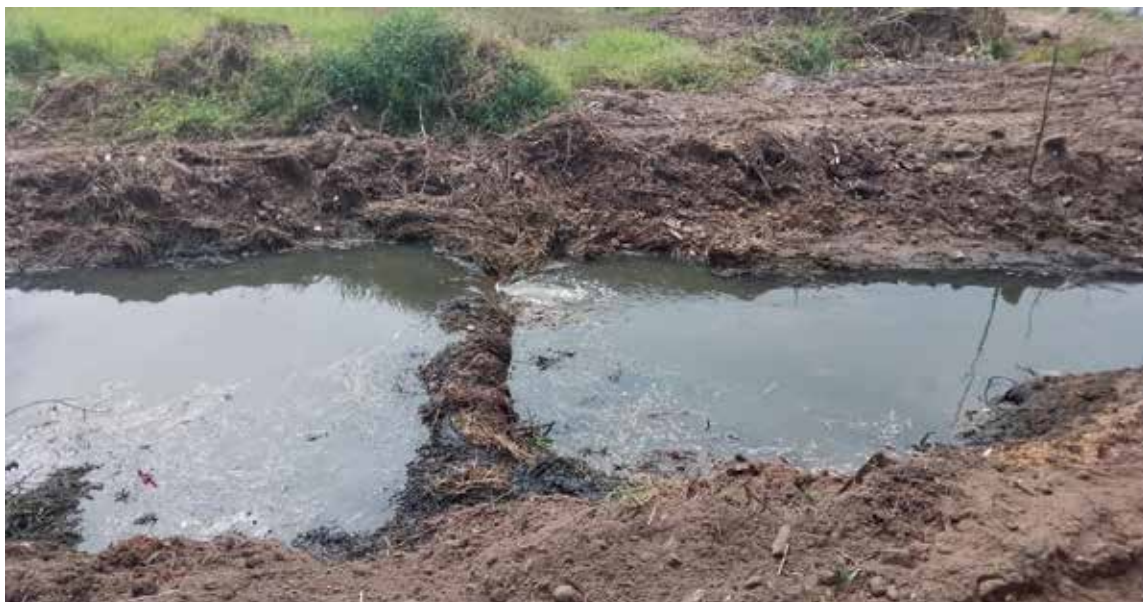
Canal provisório – limpeza
