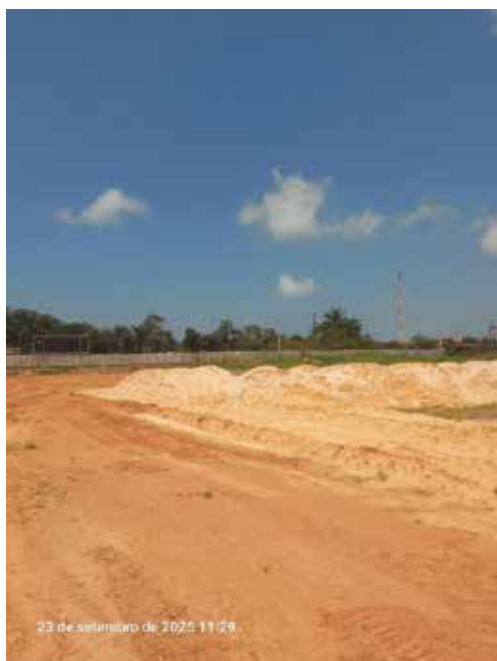
Movimentação de material de jazida
