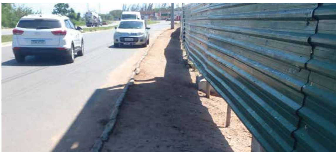
Execução de tapume frontal
