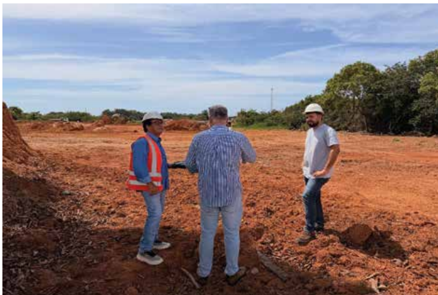
Visita técnica – Análise de solo/terraplanagem.
