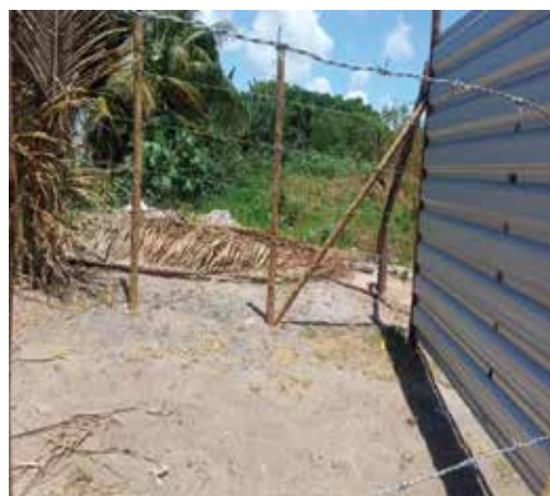
Execução de cerca perimetral
