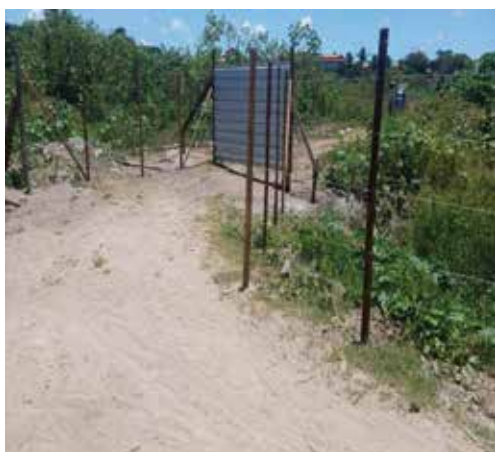
Execução de cerca perimetral
