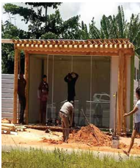
Execução de pergolado, deck e paisagismo
