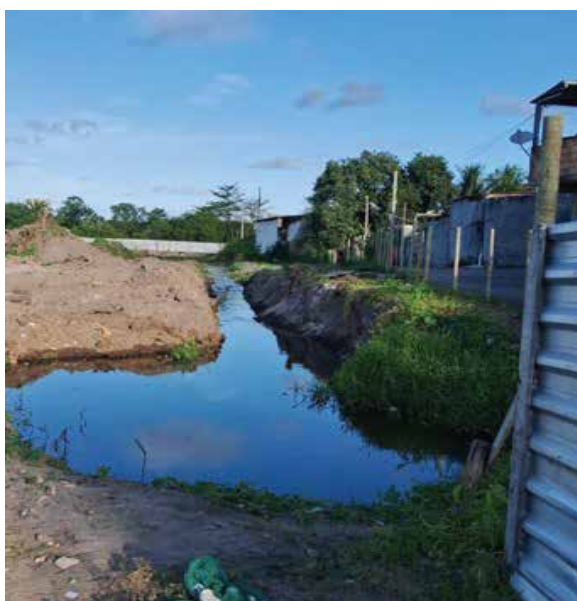
Limpeza e abertura de canal principal
