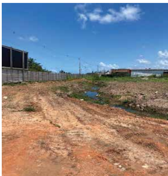
Desobstrução de canal principal
