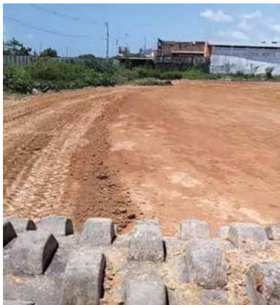
Compactação de solo
