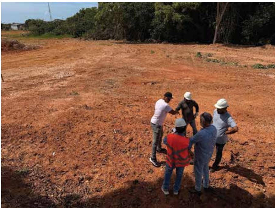
Visita técnica – Análise de solo/terraplanagem.
