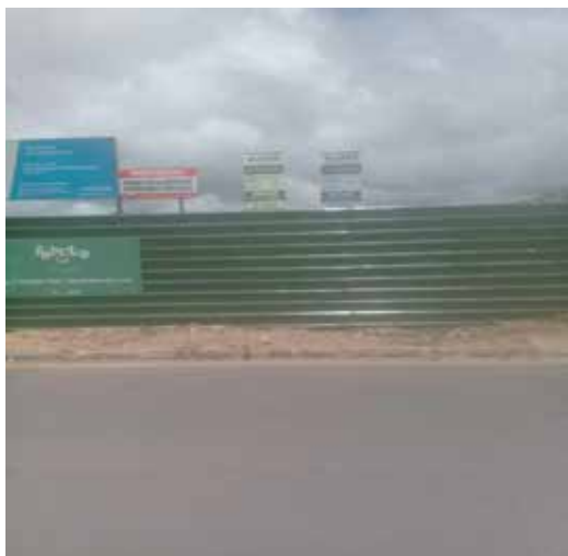
Execução de tapume frontal e instalações de placas e alvarás
