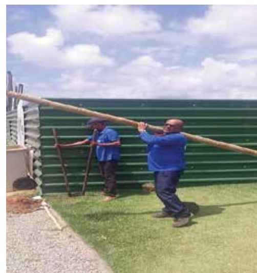
Execução de tapume frontal
