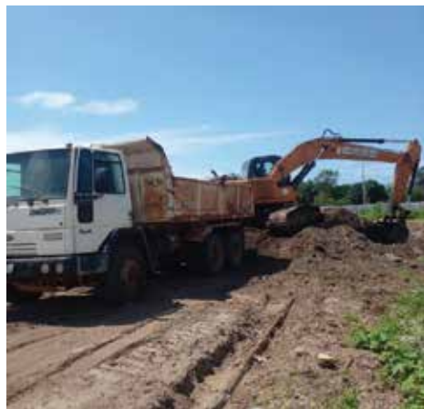
Escavadeira de esteira e caçamba
