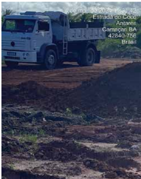
Aterramento para implantação de stand
