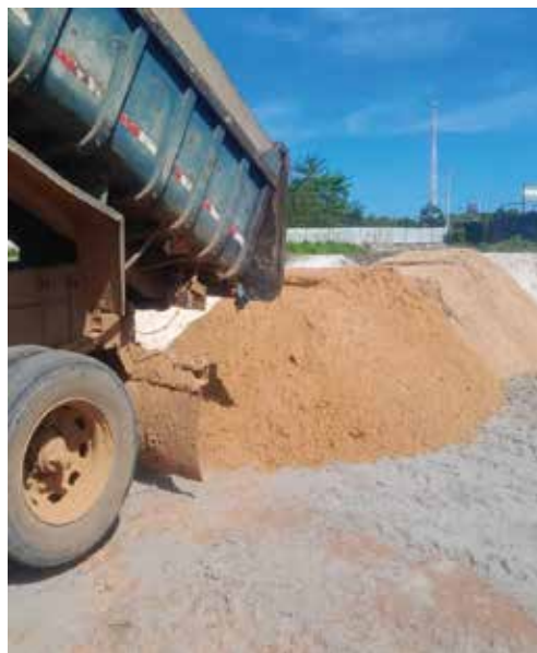
Movimentação de material de jazida
