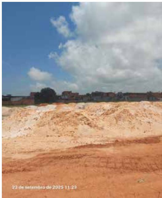
Movimentação de material de jazida
