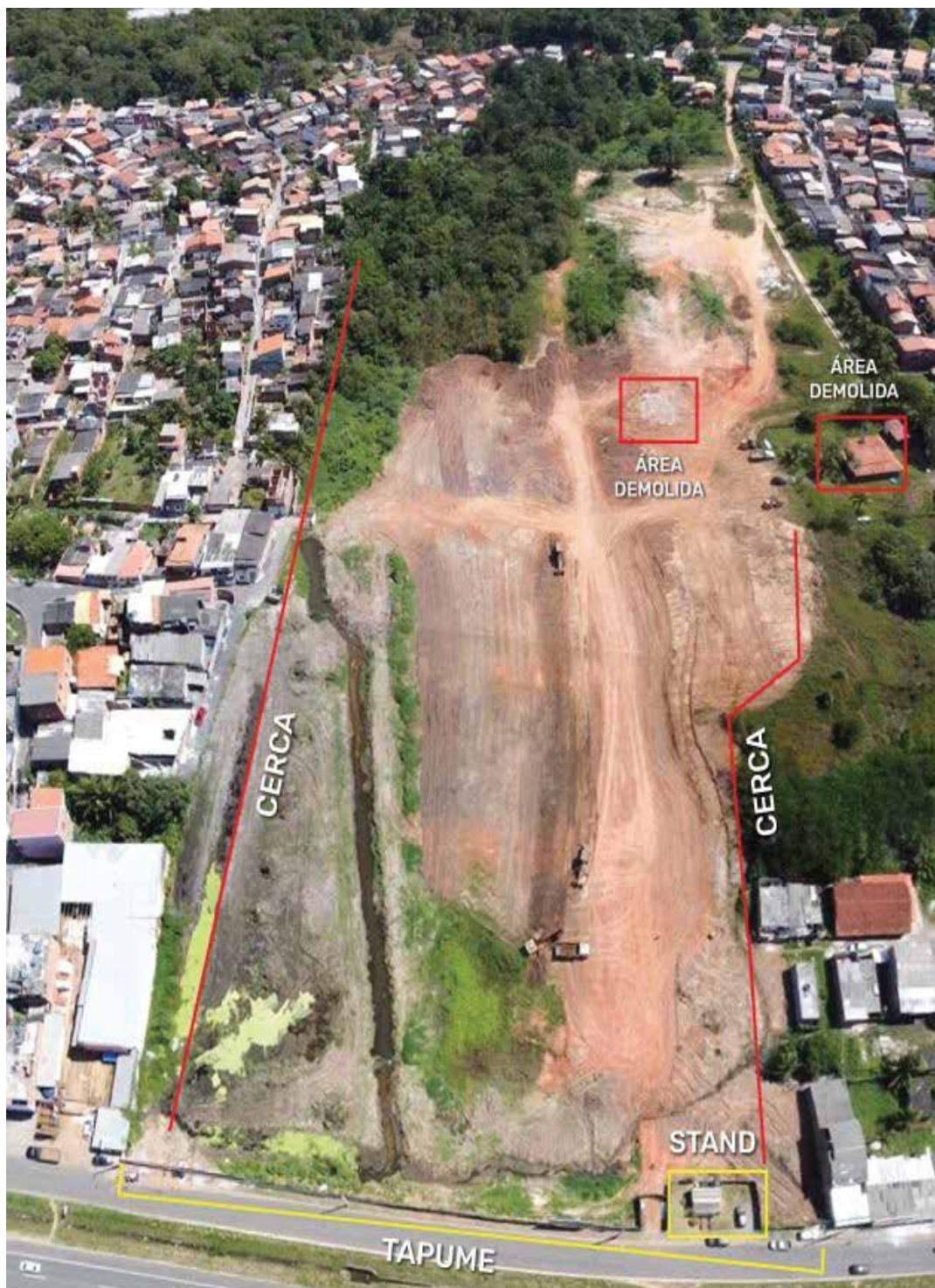
Imagem aérea: Caracterização de cerca, tapume, stand, áreas de demolições e canais.
