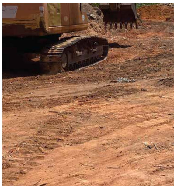
Aterramento de canal provisório
