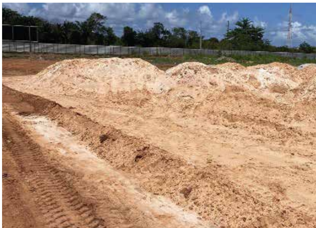
Movimentação de material de jazida
