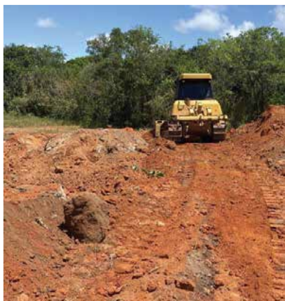
Aterramento de canal provisório
