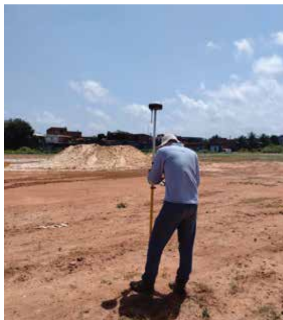
Equipe de topografia verificando pontos e cotas executivas.
